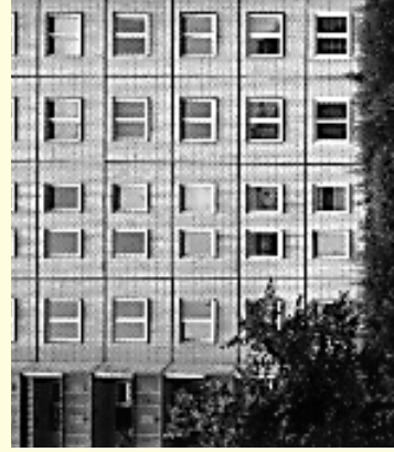
5 c Aussenwandplatte Keramik Gensler Straße 27 Hohenschönhausen
