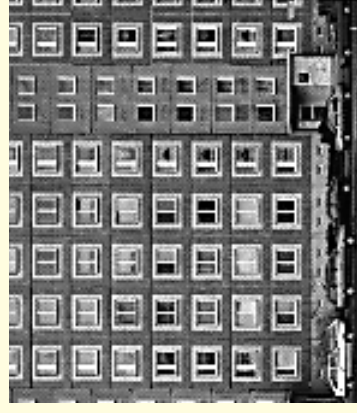
5 d Aussenwandplatte Keramik Zechliner Straße 26 Hohenschönhausen
